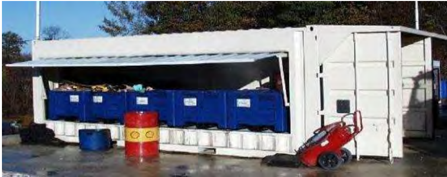
Figure 107 : Tri sélectif des déchets de chantier
